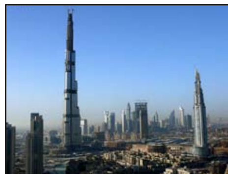
Le centre-ville de Dubaï, en constante construction
